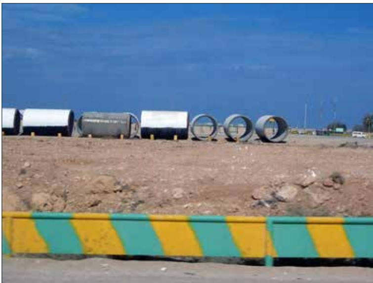
Section en travaux en 2004 de la Grande Rivière de Lybie. Wsx CC BY-SA 3.0
