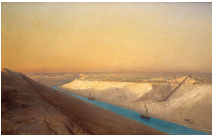
Le Chantier n°6 : l'eau de la Méditerranée arrivant dans le lac Tinsah le 18 novembre 1862, de François Pierre Bernard Barry © Souvenir de Ferdinand de Lesseps et du Canal de Suez / Lebas Photographie Paris
